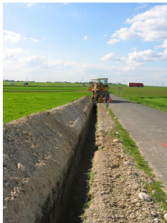
Figure 68 : Travaux de câblage électrique (source : Nordex France S.A.S.)
