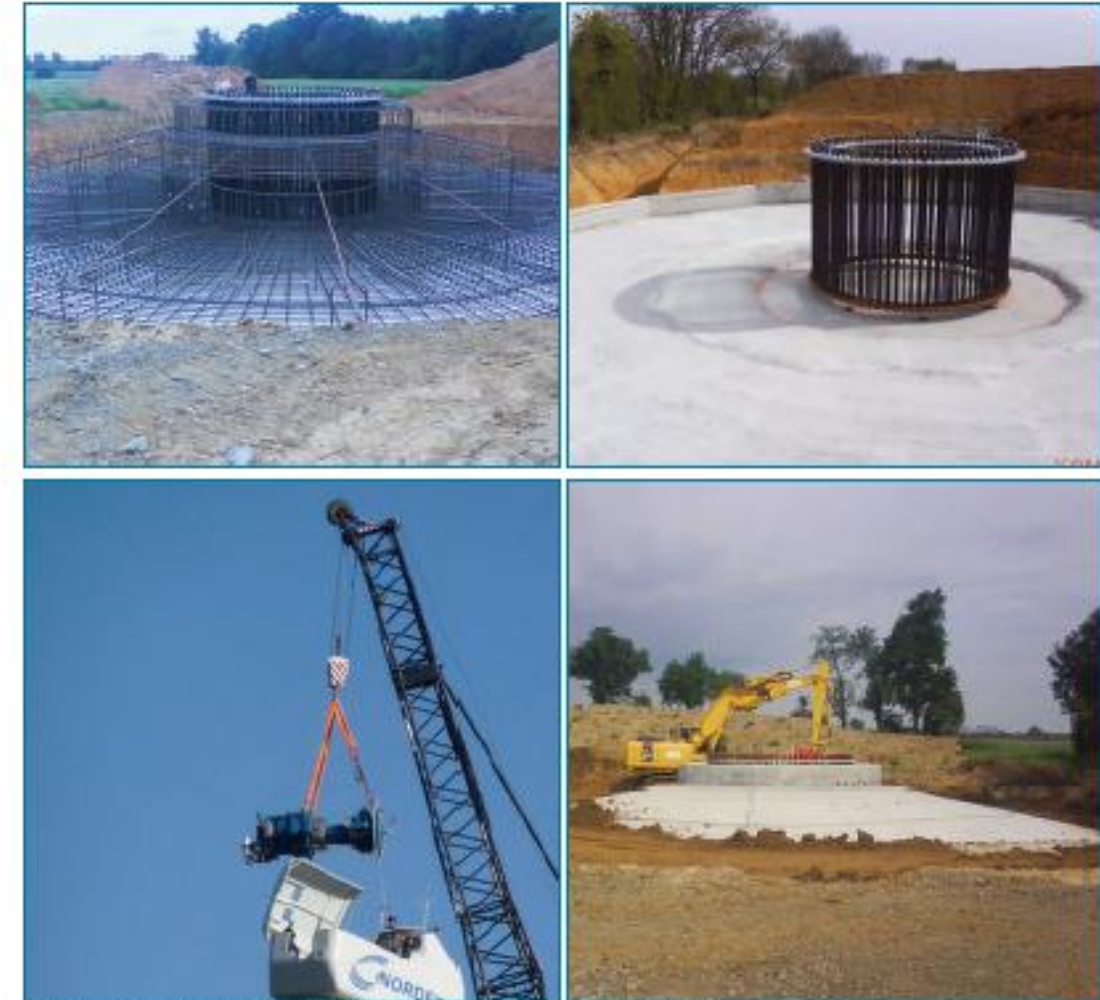
Figure 71 : Etapes de la construction d'une fondation – chantier de Crêtes et Fouy (49) (source : Nordex France S.A.S.)
