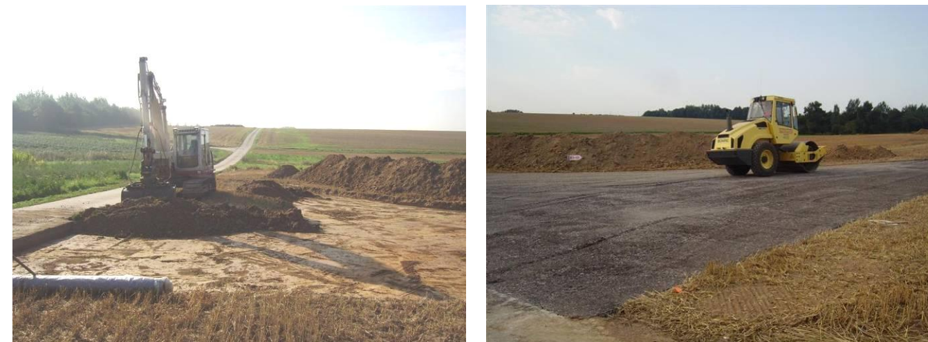
Figure 69 : Travaux pour la réalisation de chemins d'accès
